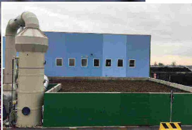
Vasche contenenti corteccia, filtri dell'aria dell'impianto di produzione ACFA visibile alle spalle.
